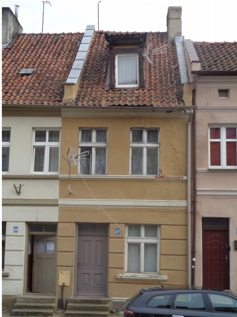
Ilustr. 1. Elewacja główna zachodnia. Na zdjęciu widoczna deformacja dachu i wychylenie lukarny z pionu.
